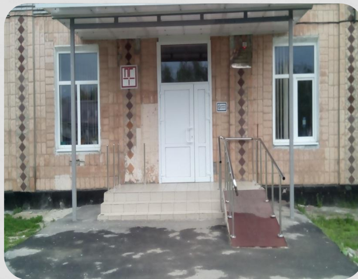
Установлен пандус с внутреннего двора школы с соблюдением нормативных требований.
